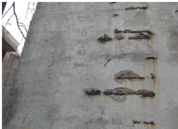
解説 写真-2.2.2 かぶりの薄い箇所における中性化による劣化事例
