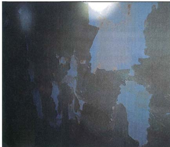
写真 7-1 表面被覆材の剥離状況
