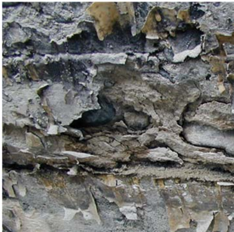
a) 樹脂の劣化部分に滞水し、コンクリートの劣化が加速
