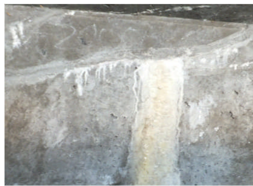
ひび割れ充填後（約1年後）の析出物
