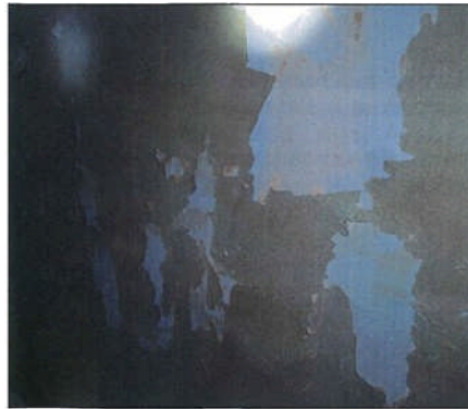
解説 図-3.2.1 気体の水分（水蒸気）の結露が要因となり発生した塗膜の剥離
