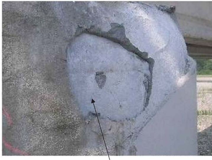
ポリマーセメントモルタルの剥離部
