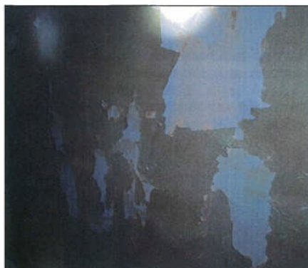
解説 図-3.1.2 気体の水分(水蒸気)の結露が要因となり発生した塗膜の剥離
