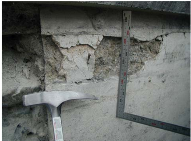
b) 樹脂が劣化していない箇所（樹脂をはがした状態） コンクリート表面は綺麗でも、浮きが確認できる箇所
