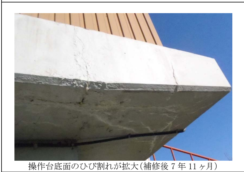
写真 17-1 コンクリート樋門の劣化状況
