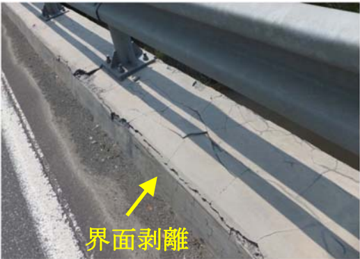
写真 14-1 地覆における断面修復材の界面剥離
