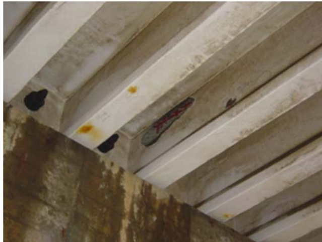
写真 20-1 表面被覆工法により補修された桁でのかぶりコンクリートの剥落状況
