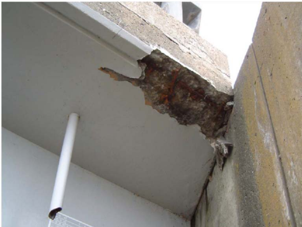
写真 19-1 床版下部における断面修復材の剥落
