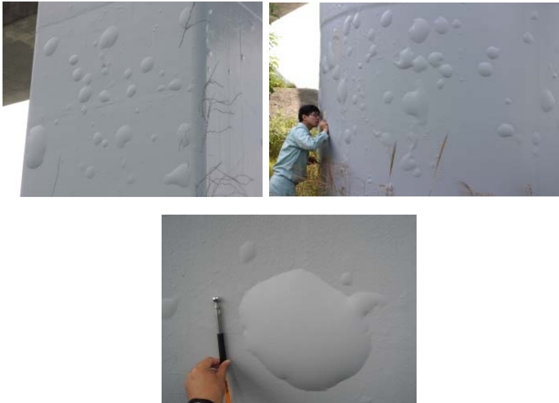
写真 11-1 下部構造における表面被覆材（中塗り）の大きな膨れ
