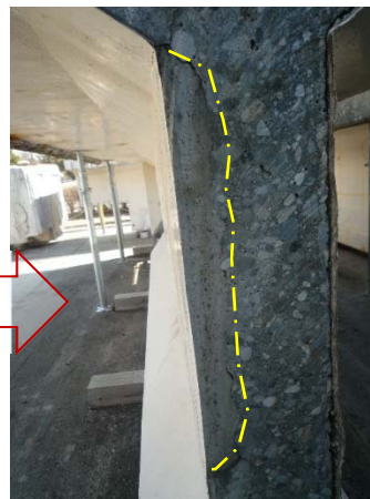
桁の切断面(断面修復部が見える)
