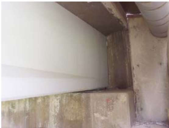
写真 10-2 桁端部における密集した膨れ
