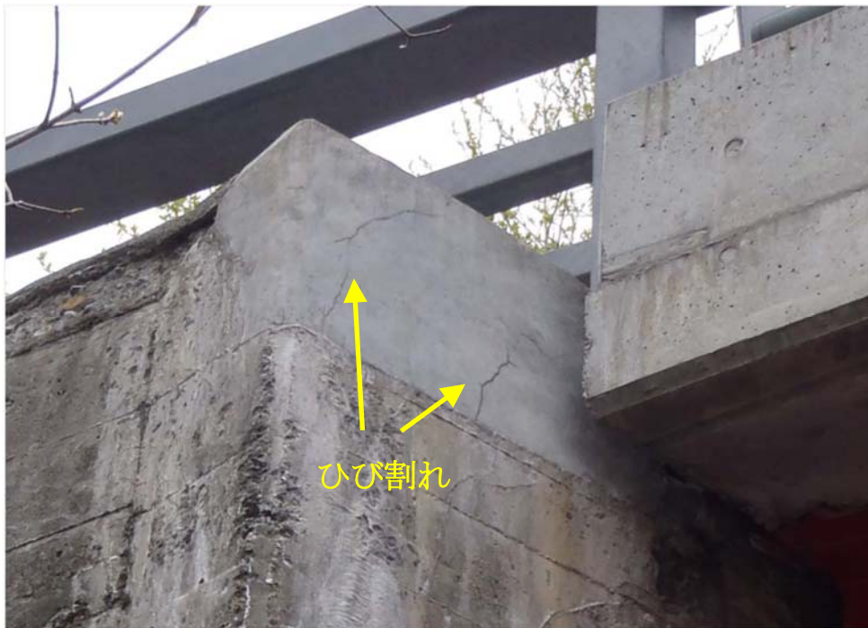
写真 13-1 橋台における断面修復材のひび割れ
