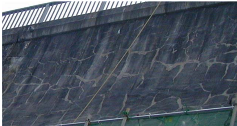
b) モルタル表面のひび割れ
