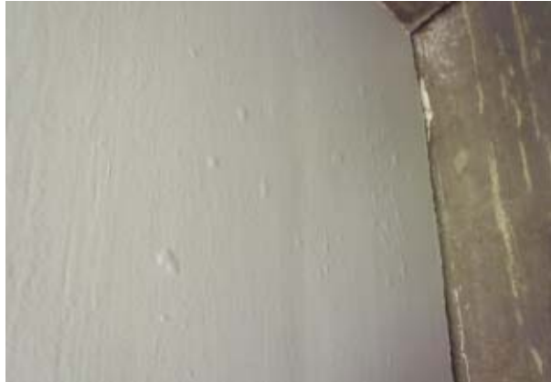
写真 10-2 桁端部における密集した膨れ
