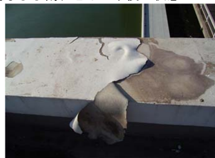
b) 塗装の剥がれ
