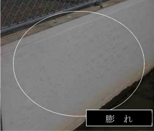
写真 2-1 表面被覆材の膨れ
