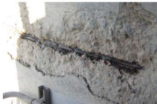
c) 浮きコンクリートを剥がしたところ、鉄筋腐食による浮きであったことを確認 (かぶり厚さは3~4cm)
