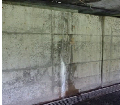
解説 図-3.1.1 ひび割れ修復工法の施工後に発生した変状の例
