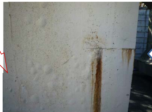
断面修復部とコンクリートの境界に沿って、ひび割れ・漏水跡。その延長上に密集した膨れが発生。
