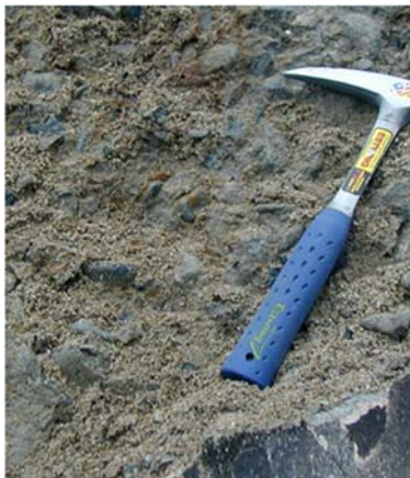
a) モルタル部分が土砂化
